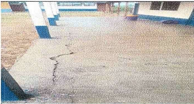
Instalacion de pisos
