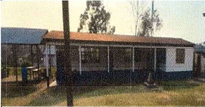
Sustitucion de laminas troquelada
