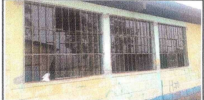
ventanas cambios de vidrios
